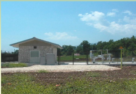
Esempio di punto di intercettazione di linea
